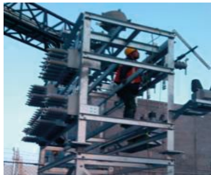
Colocación de reactores y TP de neutro
