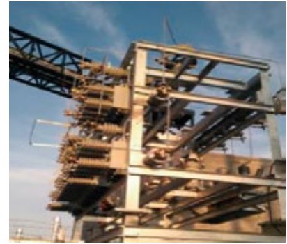
Conexión de BUS de neutro a aislador con redondo de cobre
