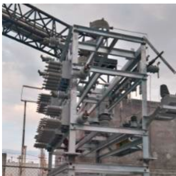
Habilitación del BUS neutro de capacitores fase 1,2 y 3
