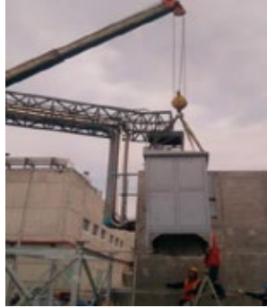
Retiro del gabinete existente
