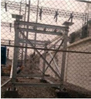
Armado de base de estructura de Banco de Capacitores
