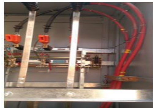
Conexión y peinado de cableado de media tensión
