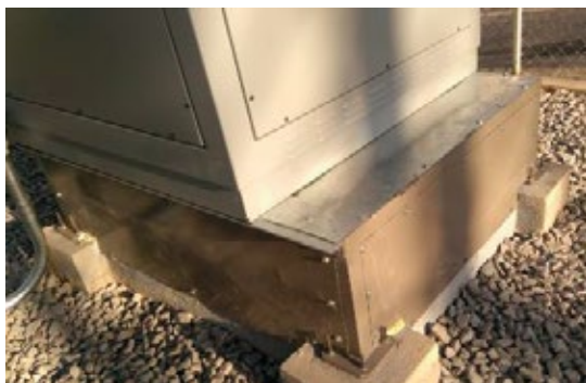
Pintado y sellado de bace de celda de media tensión
