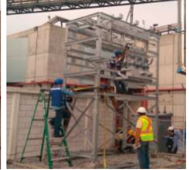
Fijación de estructura superior de Banco de Capacitores
