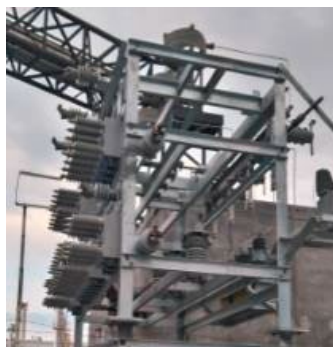
Colocación de aisladores y apartarrayos
