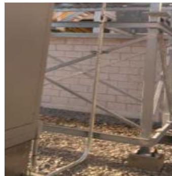
Habilitación de tubería conduit para cableado de control
