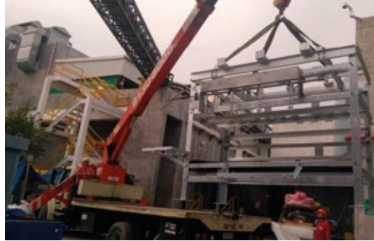
Maniobra de ubicación de estructura superior de Banco de Capacitores
