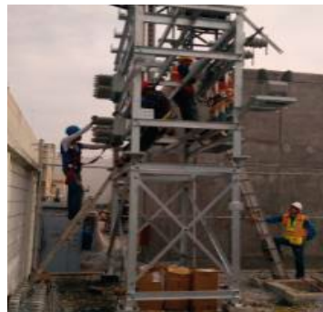
Habilitación de capacitores a estructura
