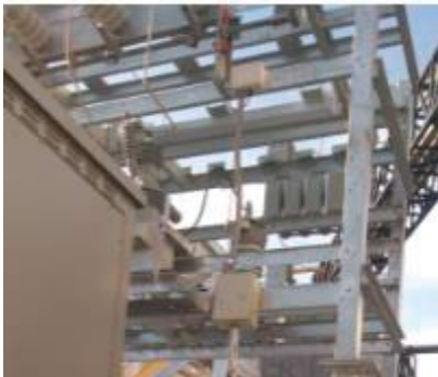
Colocación de cajas de control en estructura del Banco de Capacitores
