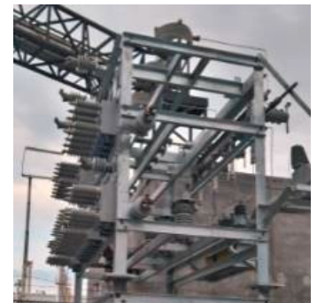
Colocación de aisladores de cuchilla de puesta a tierra
